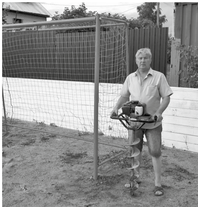
Е.И. Одинцов на строительстве спортивной площадки в д. Перекуля
