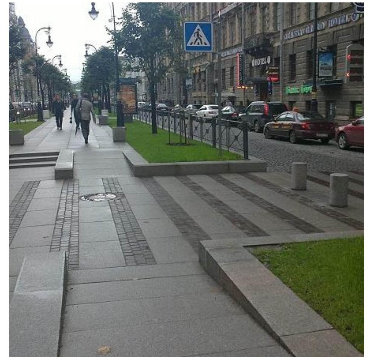
Реконструкция Большой Конюшенной улицы Санкт-Петербург, Россия 2010-2011
